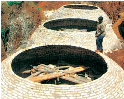
Fig. 5.13: Biogas Plant
